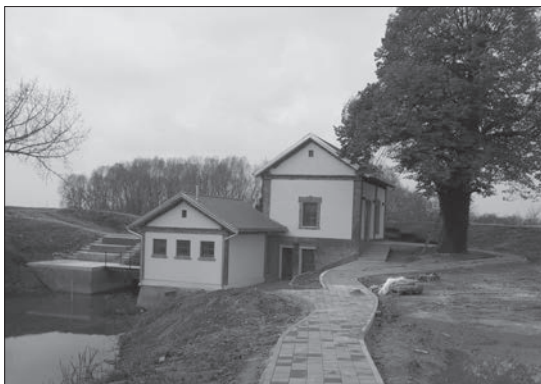
Slika 3: Zgrada Nadzorno informativnog centra nakon rekonstrukcije
